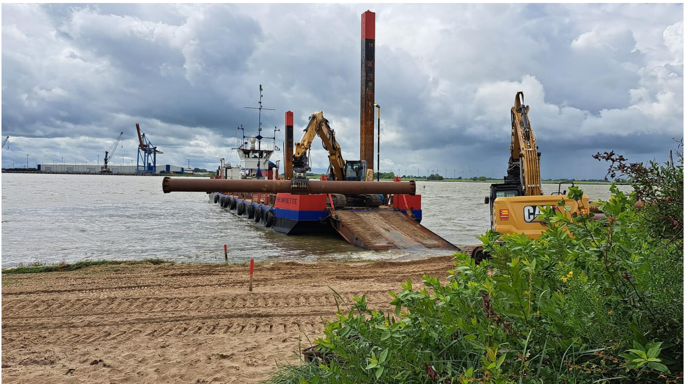
In Sandstedt wird das Aufspülen des Strandes vorbereitet. Foto: Jan Iven
