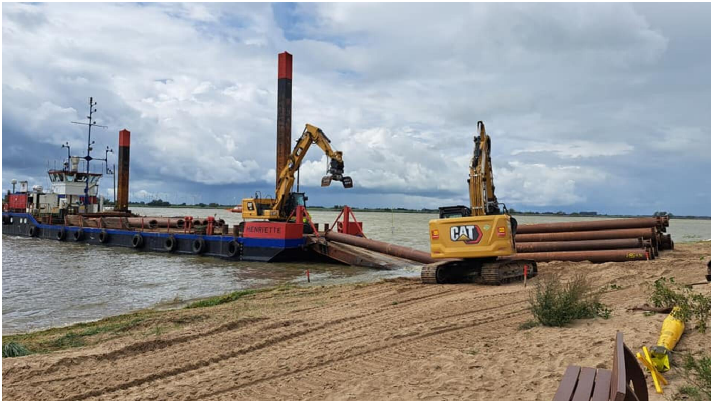
Zwei Bagger laden Stahlrohre von einem Schiff am Sandstedter Strand aus. Foto: Jan Iven
